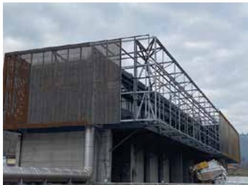
RIVESTIMENTO EDIFICIO ESISTENTE IN LAMIERA FORATA CORTEN
